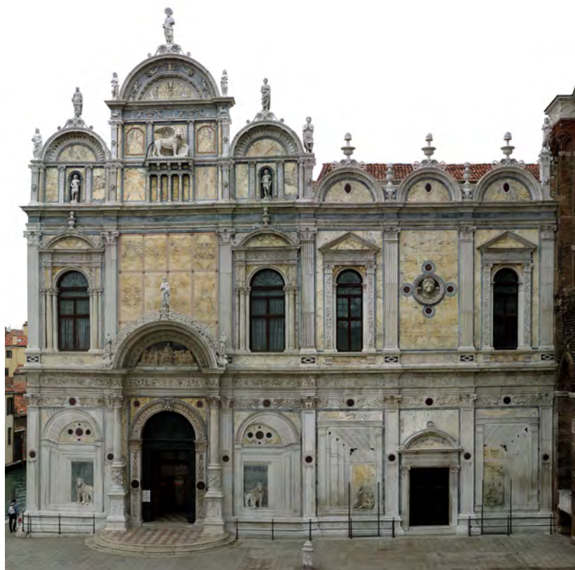
Fig. 1 Scuola Grande di San Marco, façade (photo Dino Chinellato). Courtesy of Save Venice Inc.
